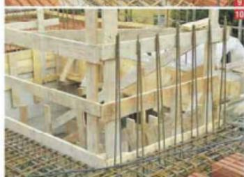
lstri in c.a. e solai in laterocemento. Le divisioni tra gli alloggi sono state previste in forati di laterizio a doppia parete con interposto isolante termoacustico. Le tramezzature interne sono costituite da mattoni forati in laterizio legati con malta di cemento grezzo di spessore minimo 12 cm. Tutti i muri sono stati intonacati con prodotti premiscelati a base di cemento. Le murature perimetrali sono composte
