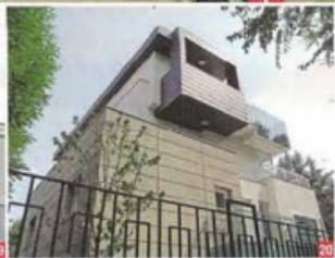
**15-16-17. Tutte le pareti di tamponamento esterno sono realizzate con blocchi di termolaterizio e rivestimento a cappotto. In linea generale il pacchetto murario è così composto: cappotto esterno di 5,5 cm o termointonaco; muratura in termolaterizio 30 cm; intonaco esterno 1,5 cm.**
